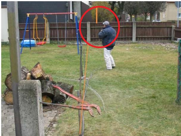
Die Bohrlanzen geben die erbohrte Richtung des Stollens an. Links vom Arm des Arbeiters ist die Markierung vom 13.12.2007 am Holzzaun angebracht. Zur Zeit der Aufnahme füllt man den Stollen mit einer flüssigen Betonmasse. Original date/time: 2008:03:04 14:52:01
