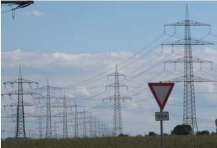
Hochspannungsleitungen mit großen Flächen zwischen den einzelnen Leitern erzeugen Magnetfelder großer Reichweite, Harmonische von 50 Hz.
