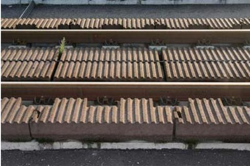
Im akustischen Bereich setzt man Bauelemente dieser Art ein, um den Lärm zu mindern. Spezielle Materialien mit geometrischen Muster zur Dämpfung im Eisenbahnverkehr.
