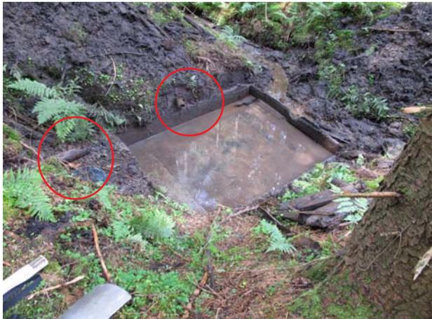
Absetzkasten mit Zulauf- und Ablaufrohr
