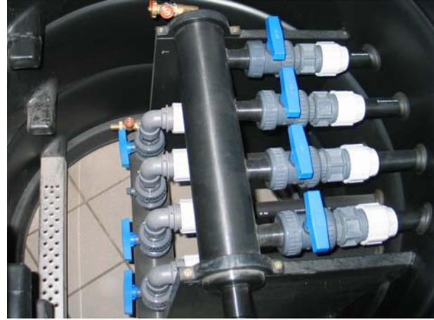
Einfache PE-Leitungen dienen hier zur Verteilung der Sole bei einer Erdwärmearanlage. Es wird dringend geraten, eine geeignete Abschirmung einzubauen, um spürbare Effekte durch zusätzliche Magnetfelder zu vermeiden. /Balck: kuehlwasser.htm/
