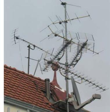
Passive Antennen auf Wohnhaus für Radio und Fernsehen bei unterschiedlichsten Frequenzen
