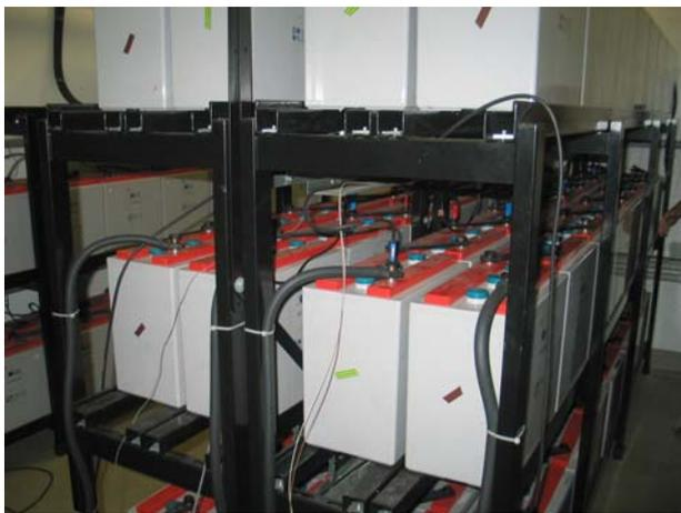
Dieser Energiespeicher im CUTEC sorgt bei Bedarf für eine autarke Stromversorgung des Gebäudes. Testeinrichtung für ein Forschungsvorhaben. Beim Betrieb der Anlage hat der Autor fluchtartig den Raum verlassen, da es hier extrem stark spürbare Effekte gibt.
