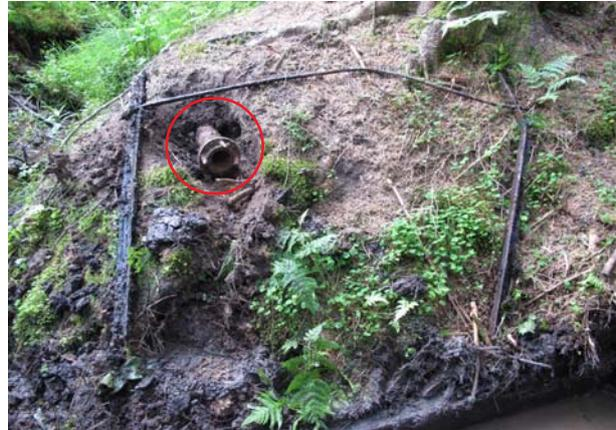
Oberhalb vom Absetzkasten ist ein eisernes Zulaufrohr. Umrahmung des Deckels aus Winkeleisen und Rundeisen
