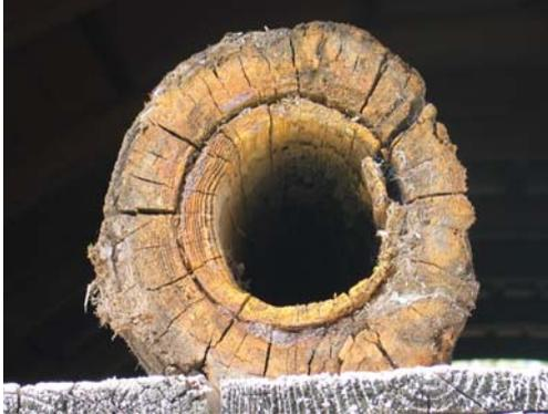
Holzrohr mit Spuren des Einschlagringes
